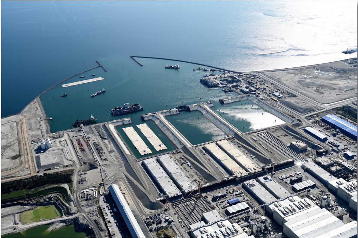
Femern Bælt's byggeplads i Rødby Havn.
