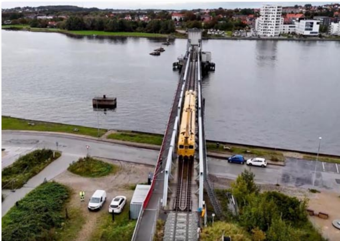
Selve boringen bliver foretaget i fjordbunden imellem gamle bropiller og den eksisterende bro. (Foto: Banedanmark)
