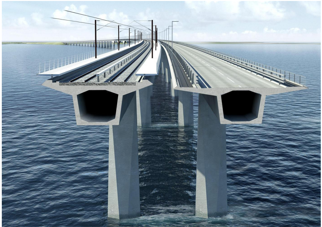
Tværsnit af en dobbeltsporet jernbanebro og vejbro med cykel og gangsti.
