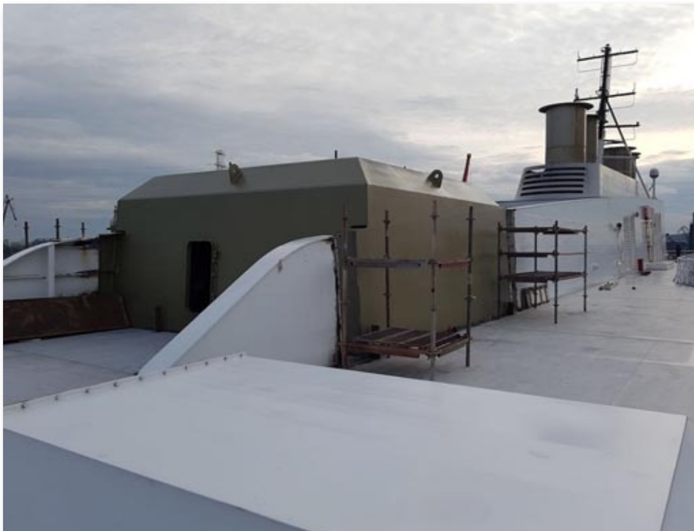
Dækket på »Copenhagen« er gjort klart med fundamentet til rotorsejlet.
